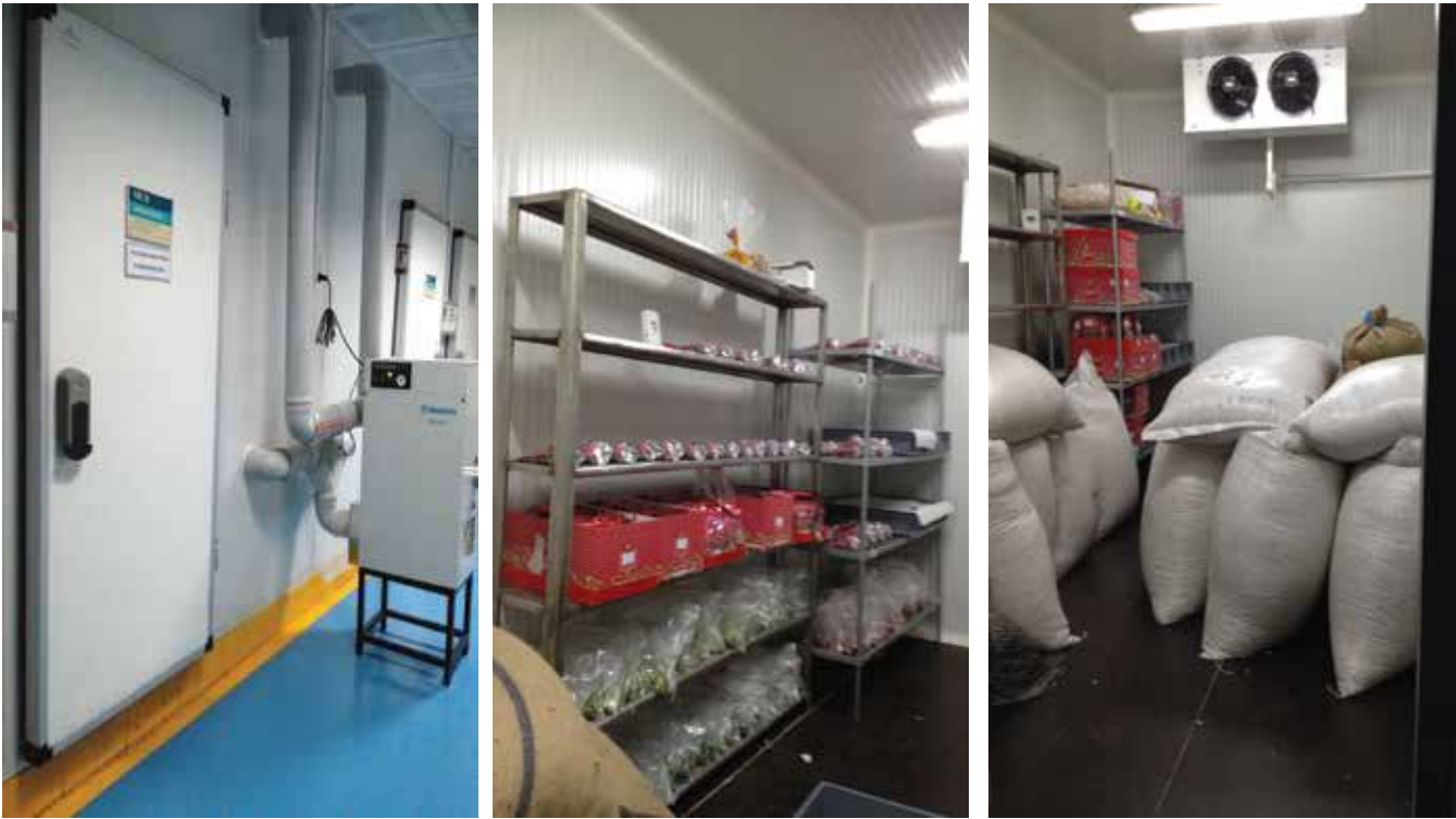
Şekil 2.3. TÜBİTAK MAM'da 10°C sıcaklıkta, bağıl nem değeri %65'i geçmeyecek şekilde cihazla (a) kontrol edilen depoda muhafaza edilen kavrulmuş paketli (MAP: azot gazı ve normal dolum) ve çuvallarda depolanan ham yer fıstığı örnekleri
